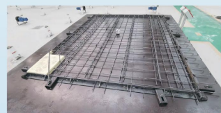
混凝土浇筑前
