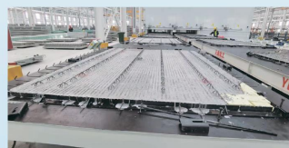
混凝土浇筑后
